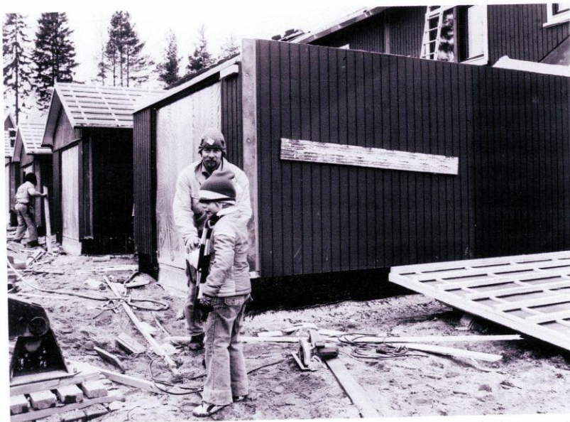
Killarna som monterade husen ropade till varandra när husets tak kom på plats: "- Det blir väl ingen taklagsfest här heller?" Så Lefte med sonen Jugge åkte och köpte en tårta som Jugge här överlämnar
