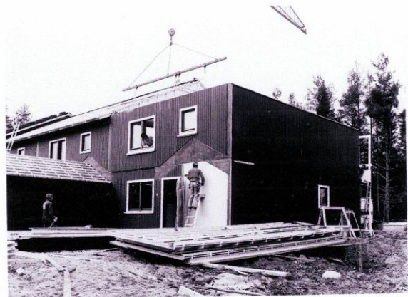
Övervåningens framsida på plats
