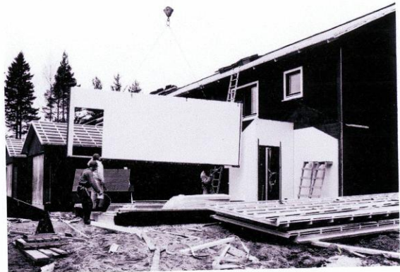
Garagesidan med dörröppningen till "soprummet"
