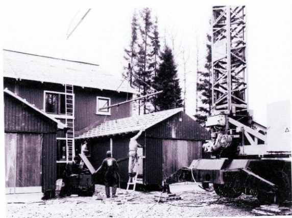
Garagetaket på plats
