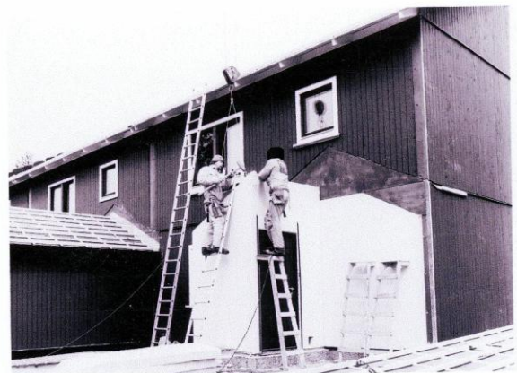
Här byggs "smygen" mellan huvudingången och "bakdörren" till garaget.
