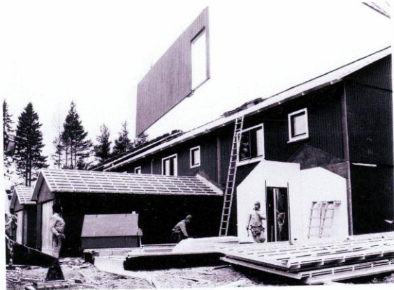
Garagesidan med dörröppningen till "soprummet"
