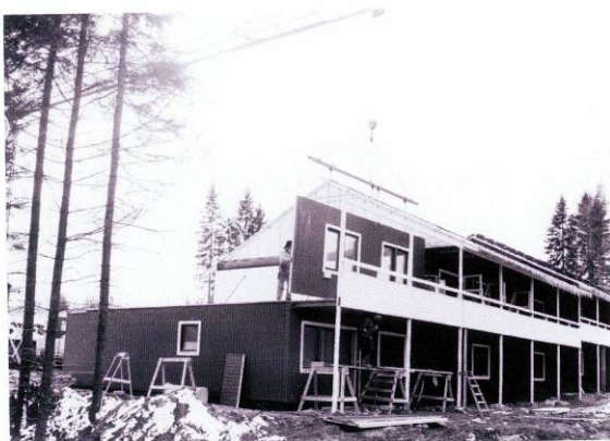
Baksidan av övervåningen med balkongdörren nästan på plats.
