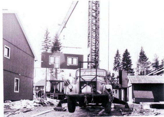
Baksidan av övervåningen med balkongdörren är på väg
